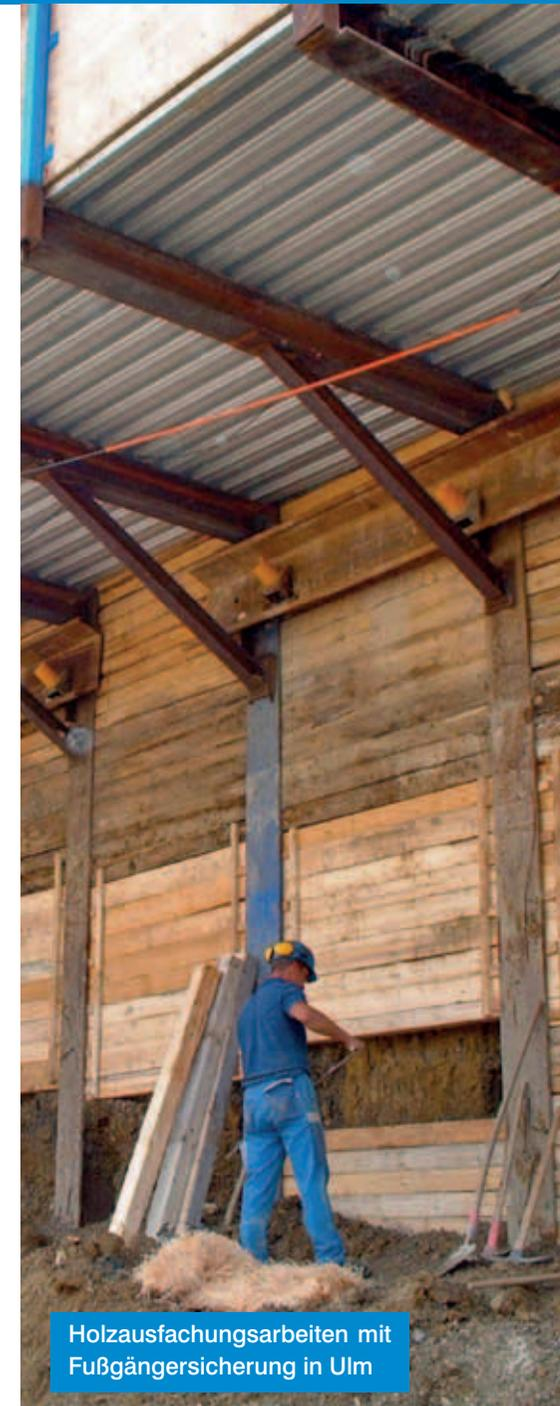
Holzausfachungsarbeiten mit Fußgängersicherung in Ulm
